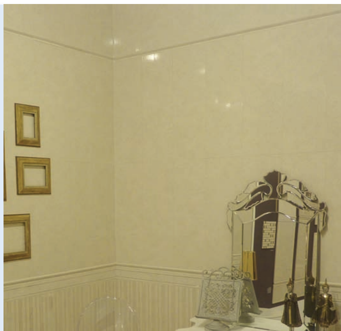
Alicatado en capa gruesa de cerámica convencional.
